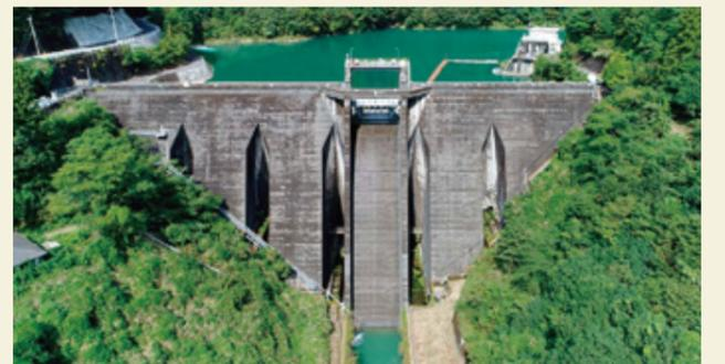
建造コストを抑えるため、中が空洞になっている重力式ダム。空洞部分があるためダムの敷地面積が広くなり安定する、という利点もあり。ダムの下流側には、5つのスリット(切れ目)が入っている。九州で中空重力式ダムが見られるのはココだけ。
