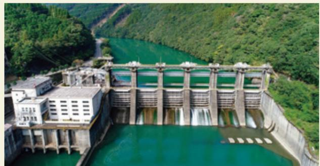
耳川水系の最下流に位置する発電専用の重力式ダム。ゆえに、ほかの耳川系ダムと違いダム直下に大きな発電所を持っているのが特徴。耳川水系の下流への一定以上の水量を確保する役割も併せ持っている。
