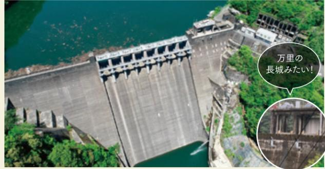
日本初の可動式ケーブルクレーンや近代的な機械化施工の導入など戦前の土木技術の粋を集めて建設されたダム。凹凸型をしたダムの天端は、万里の長城をイメージしたと言われる。文化庁の登録有形文化財に指定、また経済産業省登録の近代化産業遺産でもある。
