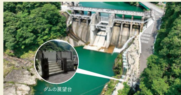
耳川で2番目に出来た歴史あるダム。2022年に約11年をかけたリニューアルが完了。新設された大型ゲートは、ラジアルゲートで国内最大の面積。大型ゲートの門柱には、西洋の城壁を思わせる凹凸も。※出入口は、国道のトンネルとの交差点となっているためご注意ください。
